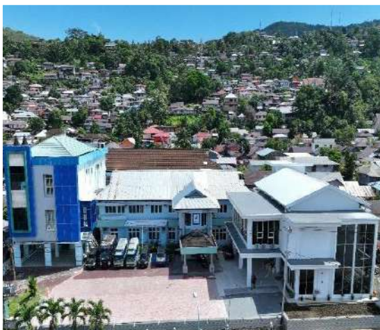
Gambar 22. Gedung Balai POM di Ambon
